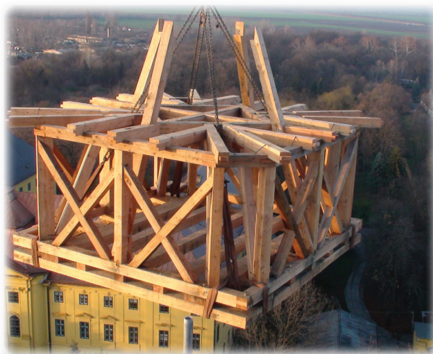
Kalocsai székesegyház toronyszerkezete
